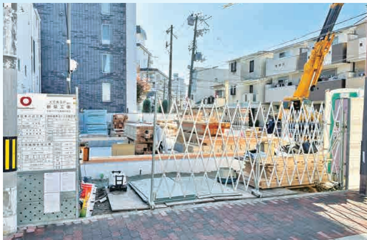
「大宮集会所」の建て替え工事が始まっています。
